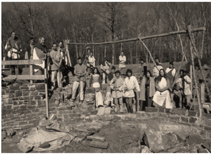
Der Bautrupp steht bereit
